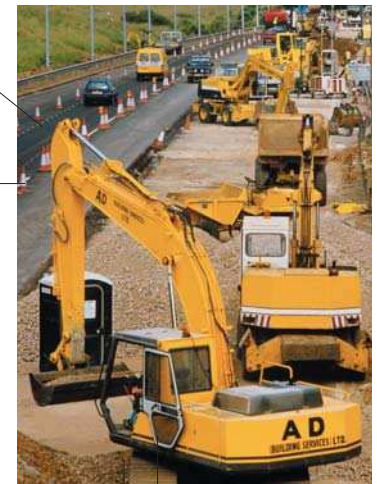
le revêtement resurfacing
