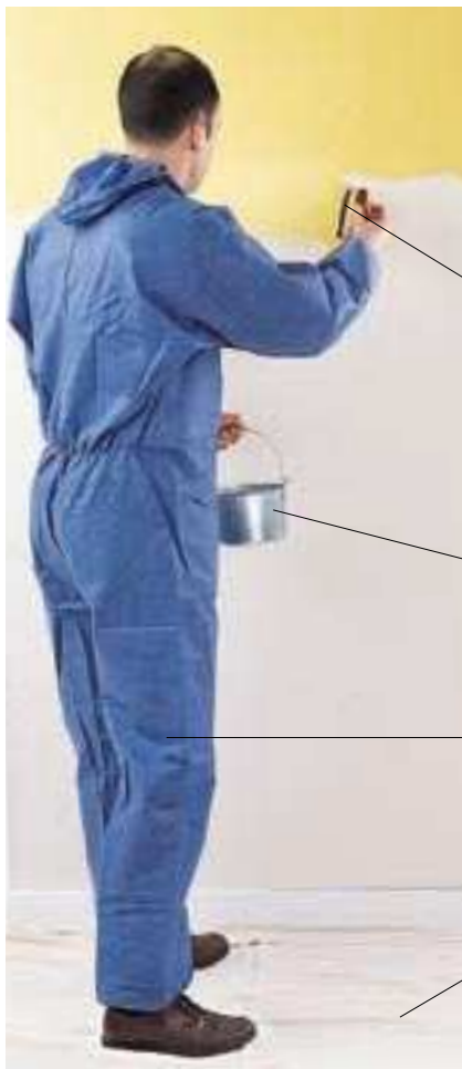
peindre paint (v)
