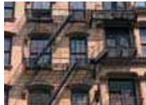
l'escalier de secours fire escape
