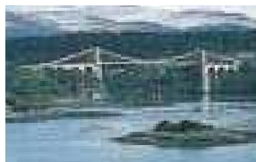
le pont bridge
